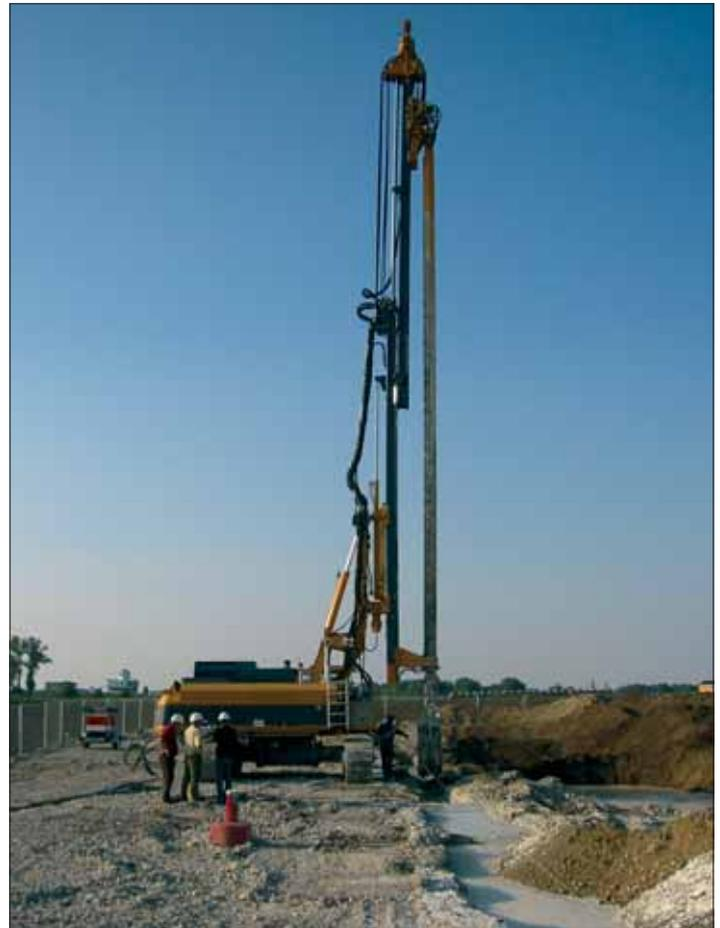
Bei der herkömmlichen Schlitzwandgreifertechnik wird der anstehende Baugrund durch die Dichtwandmasse mit einem anteiligen Bodeneintrag während der Herstellung ersetzt. Der standortbedingte entstehende kontaminierte Aushub hätte auf Sondermülldeponien entsorgt werden müssen. Das CSM-Verfahren verwendet dagegen den anstehenden Baugrund als Baustoff und vermengt diesen mit Dichtwandsuspension zu einer Dichtwandmasse. Die Entsorgungskosten für anfallenden Aushub wurden somit minimiert.
